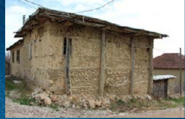
Görsel 6. G81'in doğu cephesi ve toprak dam.
