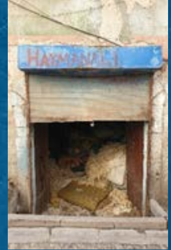
Görsel 23. Giriş kapısının ön cepheden görünümü
