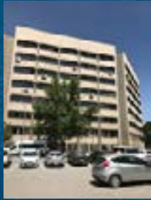
Görsel 10. Büyükşehir Belediyesi arka cepheden görünüm, 2017 (URL 5)
