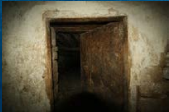
Görsel 7. 105 ada 2 parseldeki evin "koz" girişi
