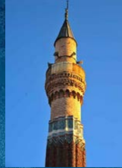
Fotoğraf 26. Sahip Ata Cami minaresi uyumsuz kaplamaları (URL-3)
