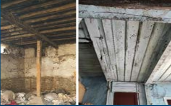
Görsel 20. Zemin kat tavan kaplaması örnekleri
