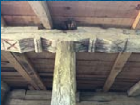
Görsel 14. Çürüyen Mertek – Değiştirilen Çatı Elemanları (Aktaş, 2022)
