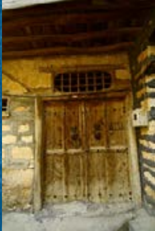
Görsel 18. 120 ada 17 parseldeki evin giriş kapısı
