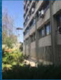
Görsel 11. Büyükşehir Belediyesi arka cepheden görünüm, 2016 (URL 6)
