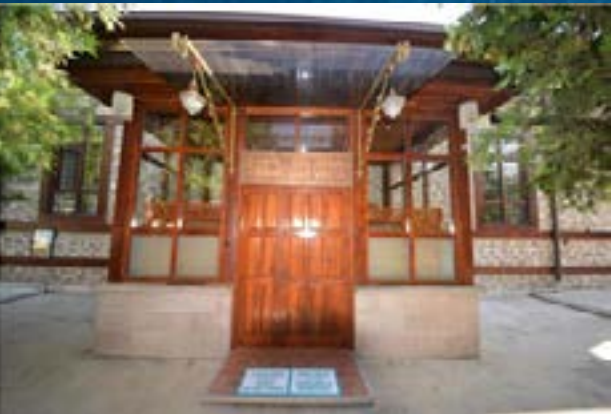
Fotoğraf 24. Sahip Ata Cami ilave edilmiş rüzgarlık kısmı (Erdem, 2019)
