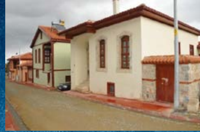
Görsel 3: Cumba yer almayan Sokak Cephesi (Kişisel Arşiv,2021).
