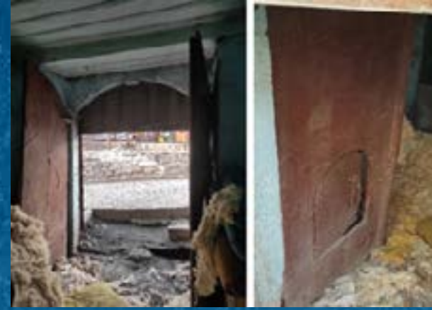
Görsel 22. Giriş kapısı fotoğrafı (a), Giriş kapısı ikinci geçiş bölmesi (b)
