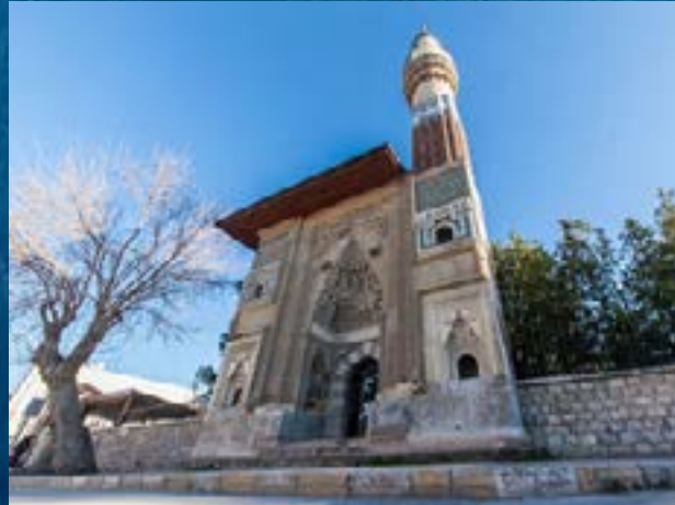
Fotoğraf 25. Sahip Ata Cami taş kapısında oluşan bozulmalar ve olmayan doğu minaresi (URL-4)
