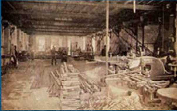
Görsel 1. Ahırkapı Kereste Fabrikasının içi (Servet-i Fünun 24 Ağustos 1311-05.09.1895, s.234; aktaran, Bülbül, 2018).
