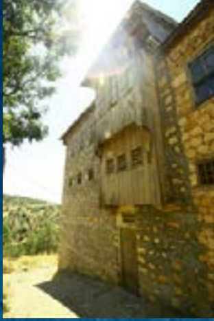
Görsel 17. 104 ada 2 parseldeki evin iki katlı çıkması
