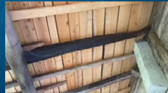
Görsel 12. Aşı Boyalı Özgün Mertekte Soba Bacasına Bağlı Olarak Görülen Bozulmalar (Aktaş, 2022)
