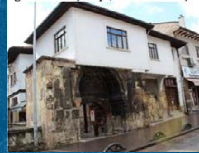
Görsel 9. Taç kapı üzerine inşa edilen yapı
