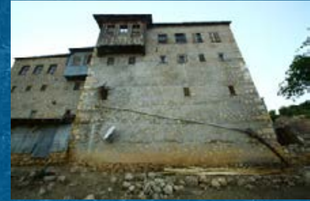
Görsel 15. 120 ada 27 parseldeki evin güneydoğu cephesi
