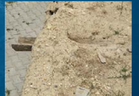
Görsel 22. 109 ada 4 parseldeki evin çatı oluğu (Aynur Çiftçi, 2012)
