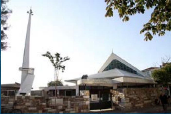
Şekil 17: Kınalıada Camisi Minaresi (URL-12)
