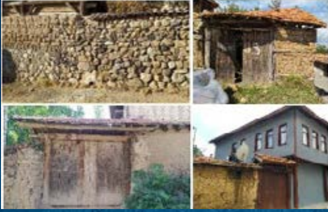
Görsel 12. Bahçe duvarı, avlu kapısı
