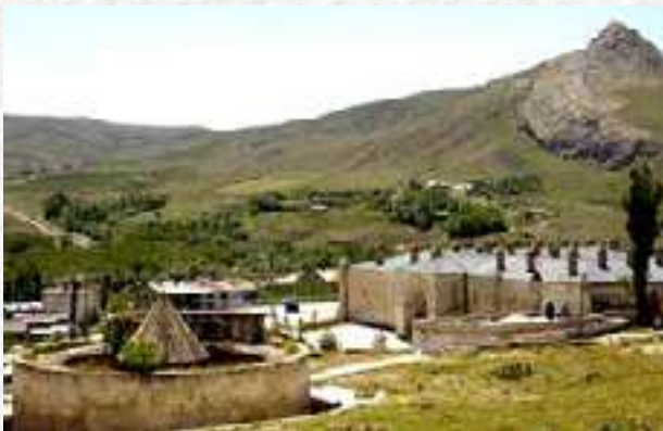
Görsel 1. Mama Hatun Yerleşimi, Kervansaray, Hamam ve Türbe Yapıları (Dick Osseman)
