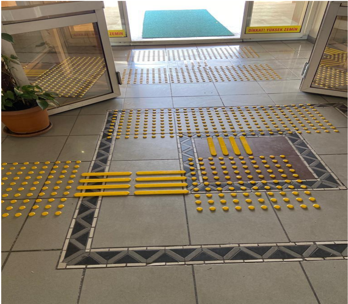
Derslik, Dekanlık ve Laboratuvar Binalarında iç mekan hassas zemin döşemesi
