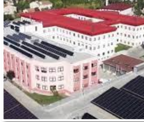
Öz Tüketimli Güneş Enerjisi Santrali
